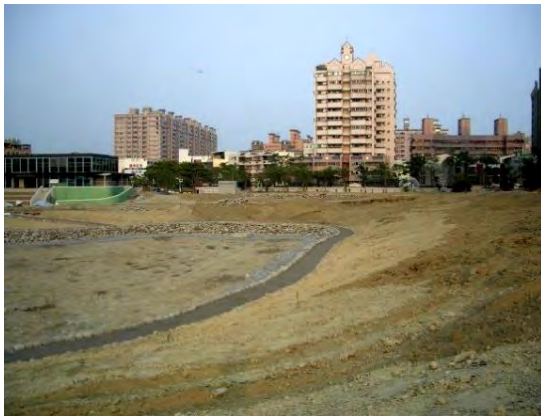
照片 1 本和里滯洪池施工(93 年)
