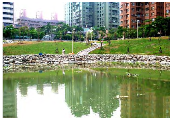
照片 2 滯洪池完工照片(94 年)
