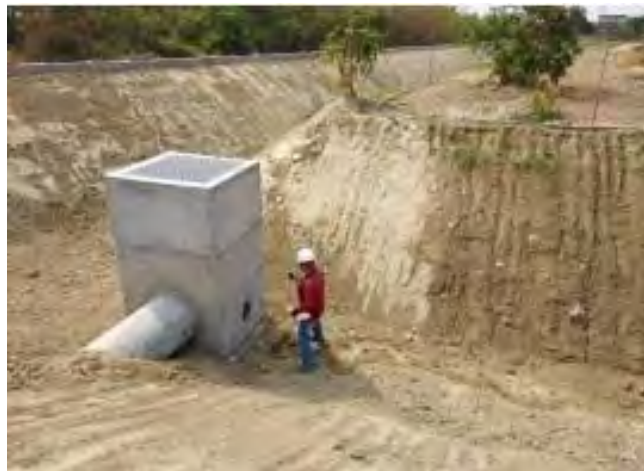
照片 4 出流管制施工督導照片
