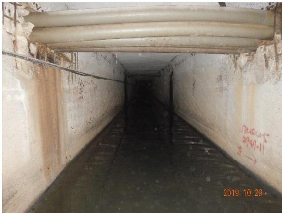
橫越管線、水流緩慢、橫越管四周破損
