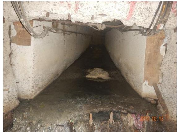
箱涵結構破損、淤積
