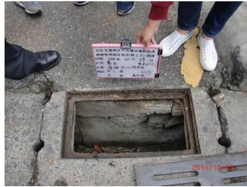
側溝結構破損
