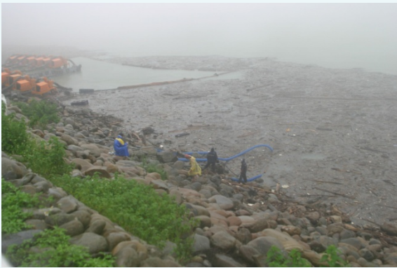
圖3-1 集水區漂流木堵塞於庫區情況
