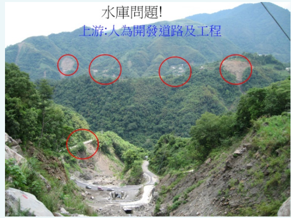
圖3-3 集水區道路及工程開闢造成淤積問題
