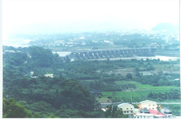
圖 1-6 九二一地震石岡壩壩頂升 7m 破壞
