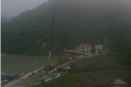
圖 1-3 石門水庫原水濁度劇增壩頂緊急抽水
