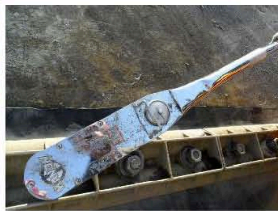
圖10 扭力扳手檢核螺栓扭力值
