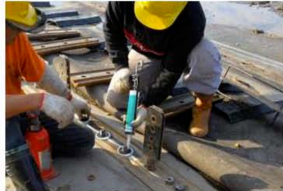
圖8 安裝時螺桿周圍施打填縫劑
