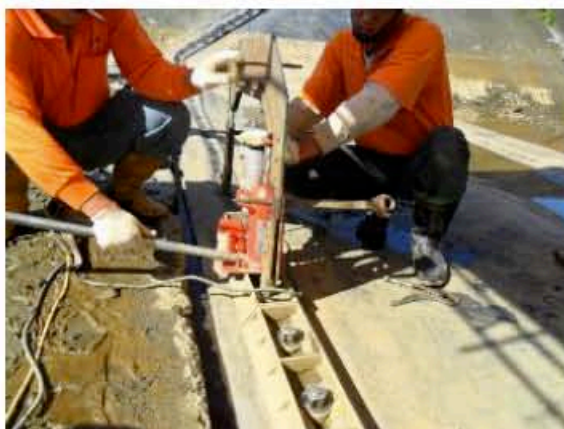
圖9 安裝時利用設備迫緊夾具
