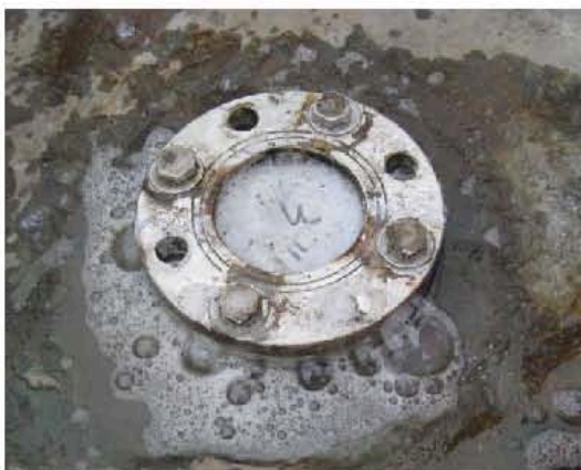
圖13 進排氣管、洩水管法蘭型式
