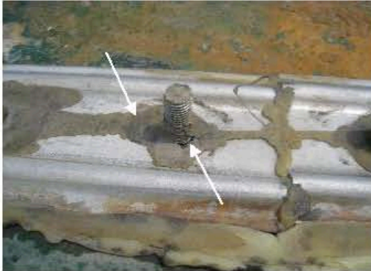
圖7 夾具固定螺桿孔隙
