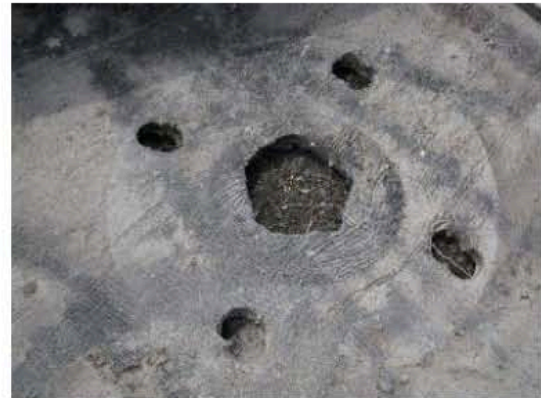
圖12 孔位不符擴孔情形
