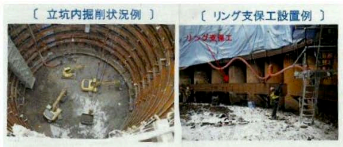
圖A9 挖方及環狀H鋼支保工架設
