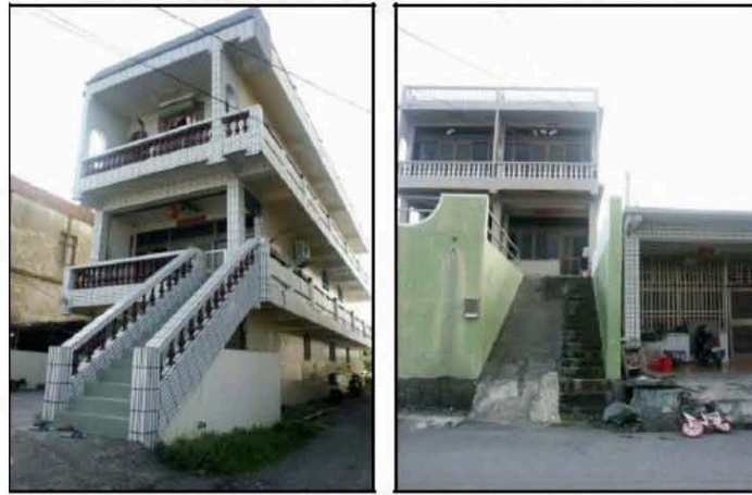
圖10 新建房屋預先墊高[10]
