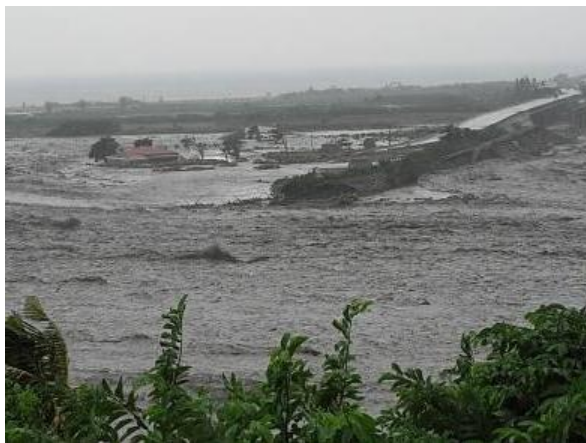
太麻里溪河口堤防潰堤
