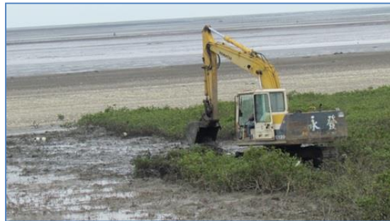
圖4 紅樹林機械清除作業流程之模擬
