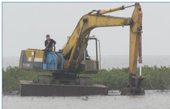
圖5 浮台改良前之紅樹林機械清除施工
