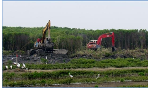
圖9 紅樹林機械清除時之雙怪手配合作業
