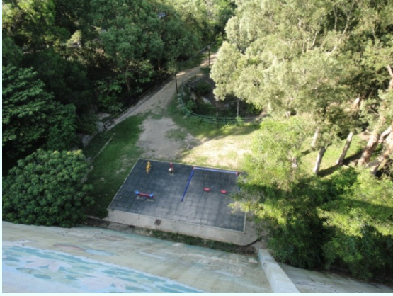
E：大壩下游側(無消能設施)
