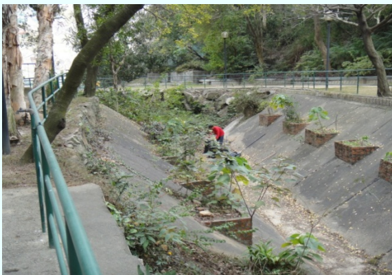
H：壩下排水渠
