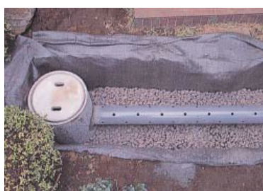
雨水滲透設施斷面圖
