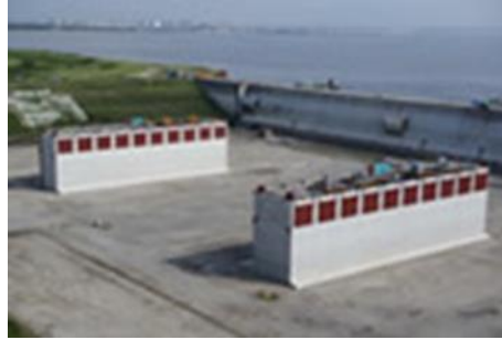
圖5. 50公尺長碼頭混合式沉箱(JFE 工程公司)
