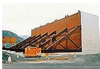
圖3. 碼頭L型混合式沉箱(JFE 工程公司)
