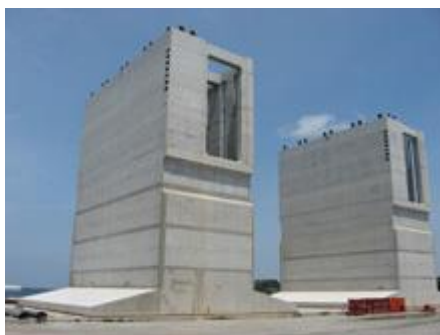
圖2. 防波堤柵欄消波混合式沉箱(日立造船株式會社)
