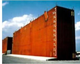
圖6. 建造中40公尺長臨時護岸混合式沉箱(JFE 工程公司)
