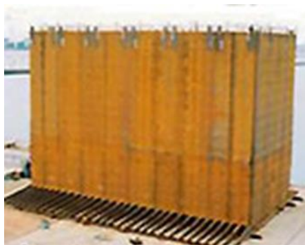
圖4. 建造中耐強震碼頭混合式沉箱(JFE 工程公司)
