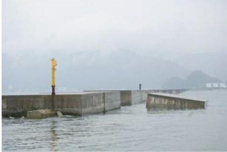
圖11. 敦賀港防波堤沉箱滑動傾斜[3]
