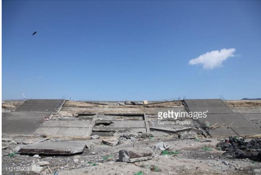
圖9. 2011日本大海嘯海堤破壞情形
