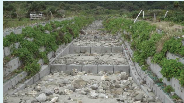
照片 14 野銀永興農場野溪整治工程 (隔一年後 103 年 10 月照片)
