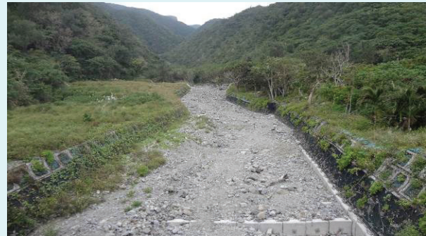
照片 16 東清 1 號橋野溪整治工程 (隔一年後 103 年 10 月照片)
