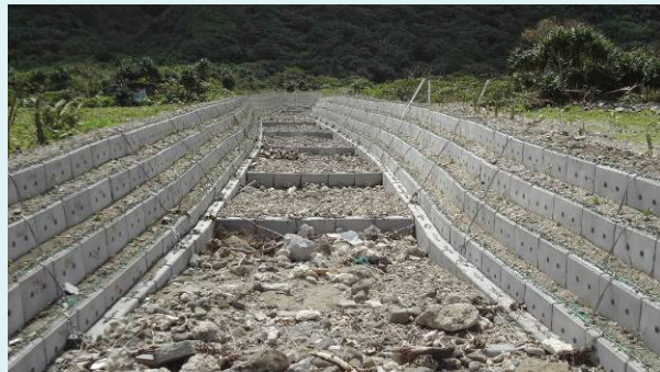
照片 13 野銀永興農場野溪整治工程 (102 年 10 月完工照片)
