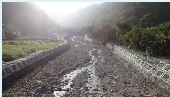
照片 15 東清 1 號橋野溪整治工程 (102 年 10 月完工照片)
