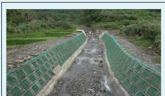
照片 3 其他小型野溪治理工程一
