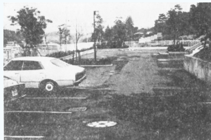
照片 2 2號調整池全景
