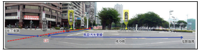
圖 3.9 污水人孔匯入點現況照片
