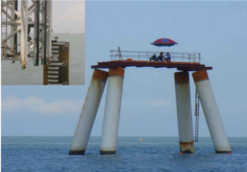
圖 12 連絡棧橋橋墩供作臨時測量平台
