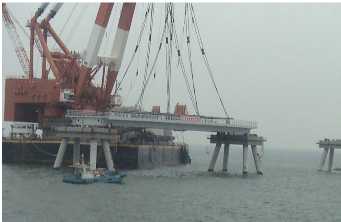
圖 15 本工程 60m 鋼橋海上吊裝作業(重 406T)
