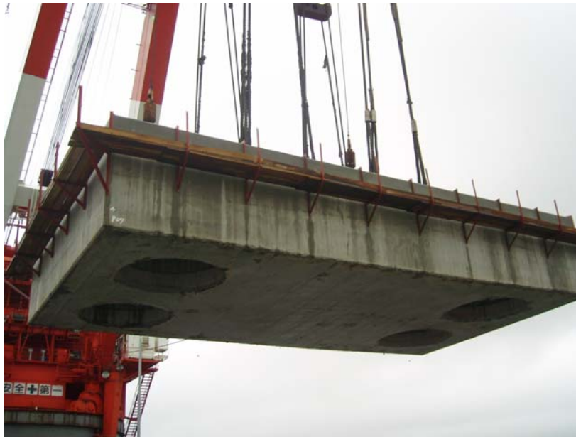
圖 14 本工程連絡棧橋預鑄化橋墩帽梁吊裝作業（13.5 x 7.4 x 2.4 m、重 550T）
