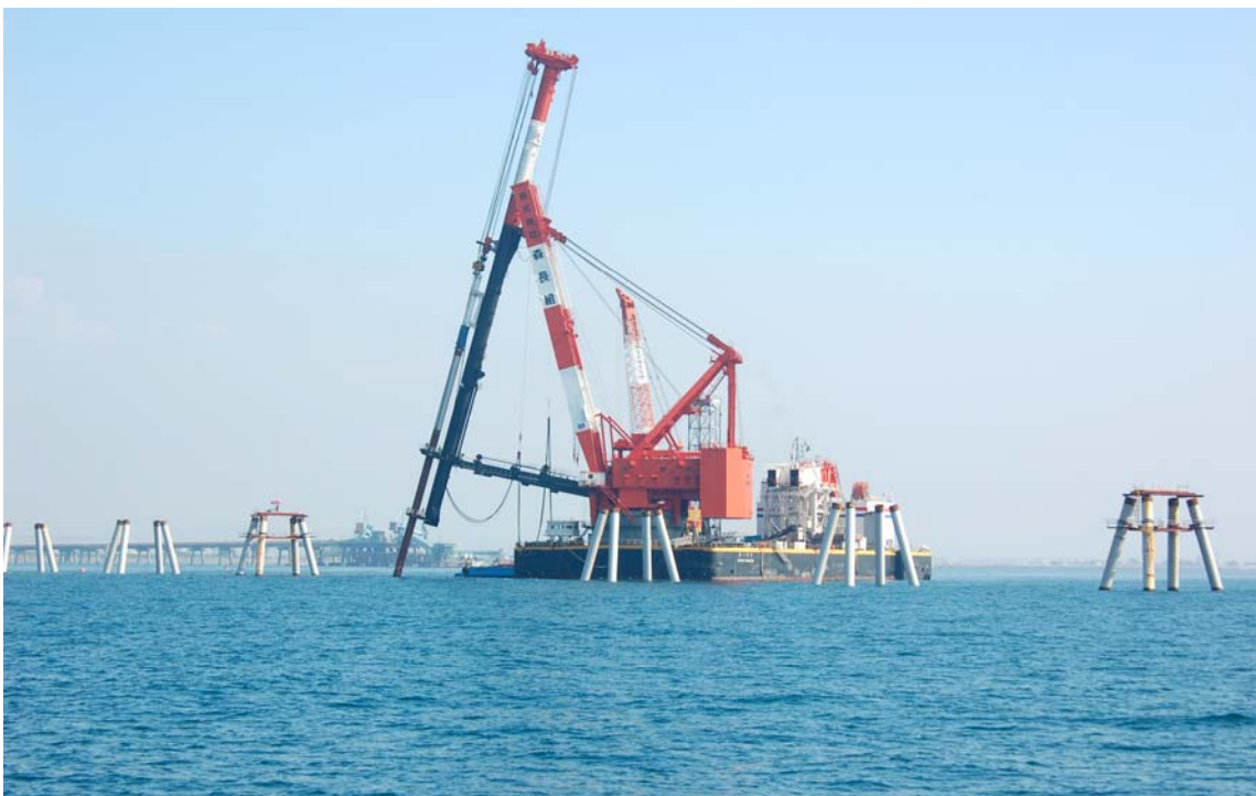
圖 13 本工程主力施工船機 1,800T 第一豐號海上斜樁打設實景
