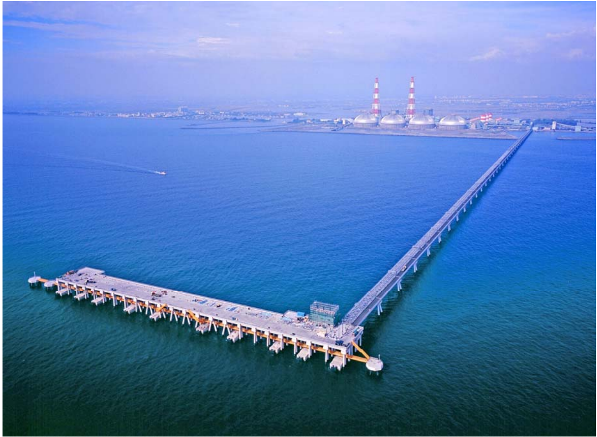
圖 16 外海卸煤碼頭及連絡棧橋完工照片
