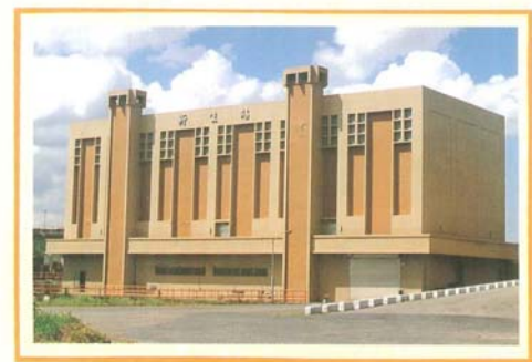
圖 4 新生抽水站站房外觀
