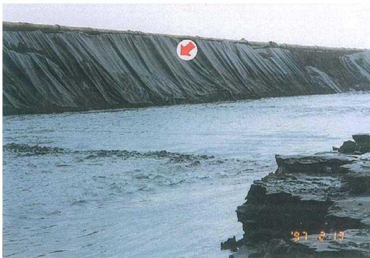
照片 8 完成之臨時圍堤
