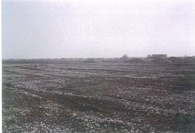
照片 10 定砂作業施工中
