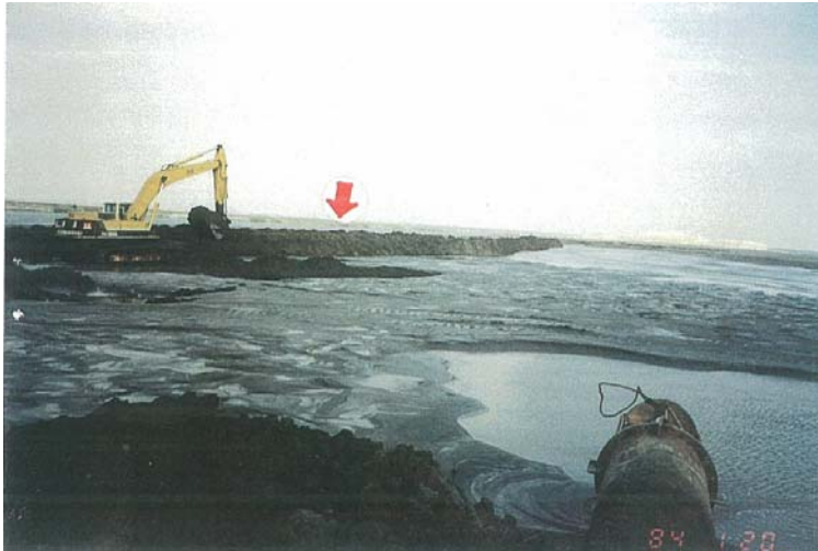
照片 7 施作中之臨時圍堤
