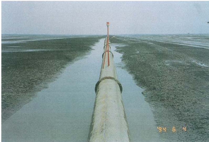
照片 5 抽砂管佈置完成並設置警示燈
