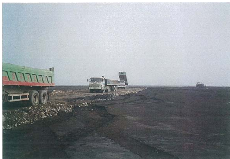
照片 9 鋪設便道
