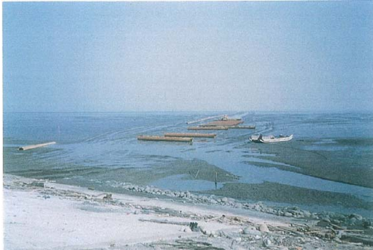
照片 2 抽砂鋼管排設
