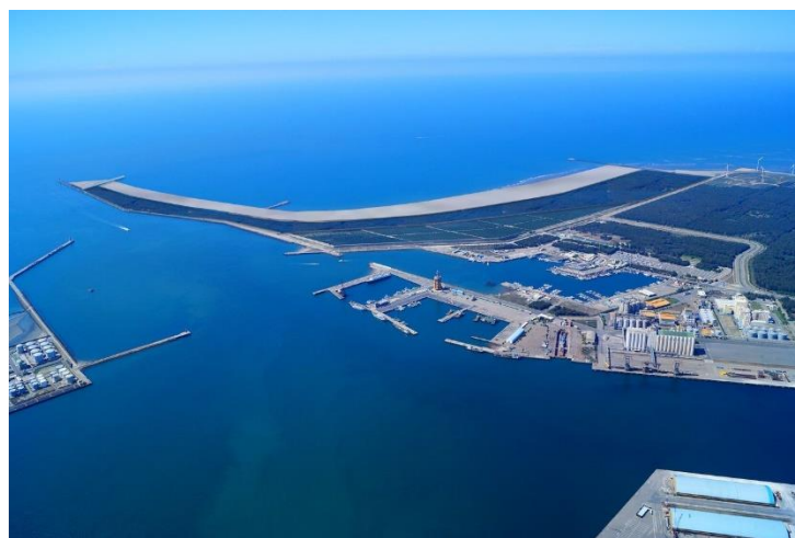
圖 10 臺中港北側淤沙區地形景觀願景
