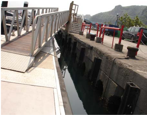
照片1，小型浮箱體與岸壁之連絡橋
