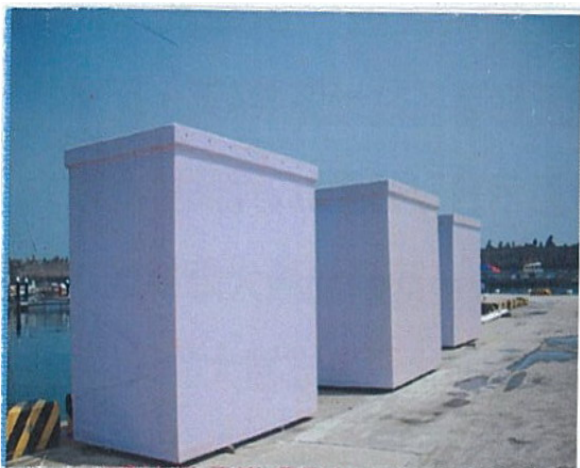
圖2, 鋼筋混凝土製浮箱(2.7M*1.7M*2.7M)
