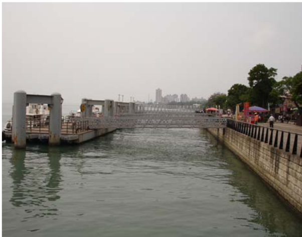
照片2，大型浮箱體與岸壁之連絡橋
