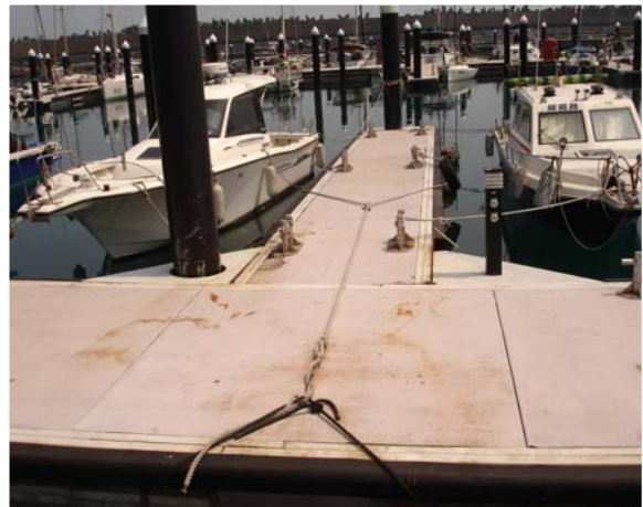
照片4，浮箱固定於鋼管基樁
