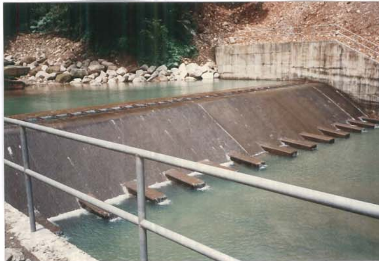
主堰完工蓄水現況
