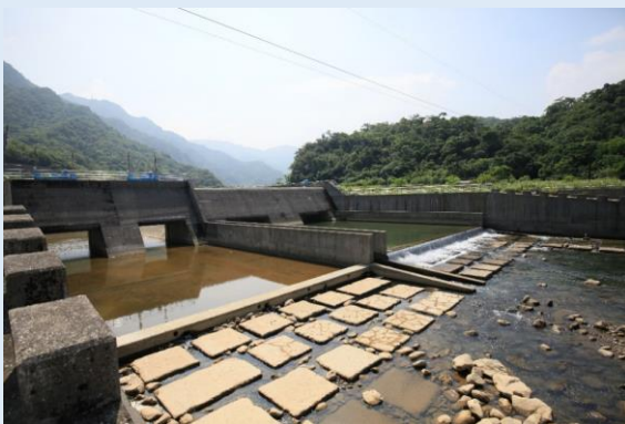
基隆河排洪道下游設施
