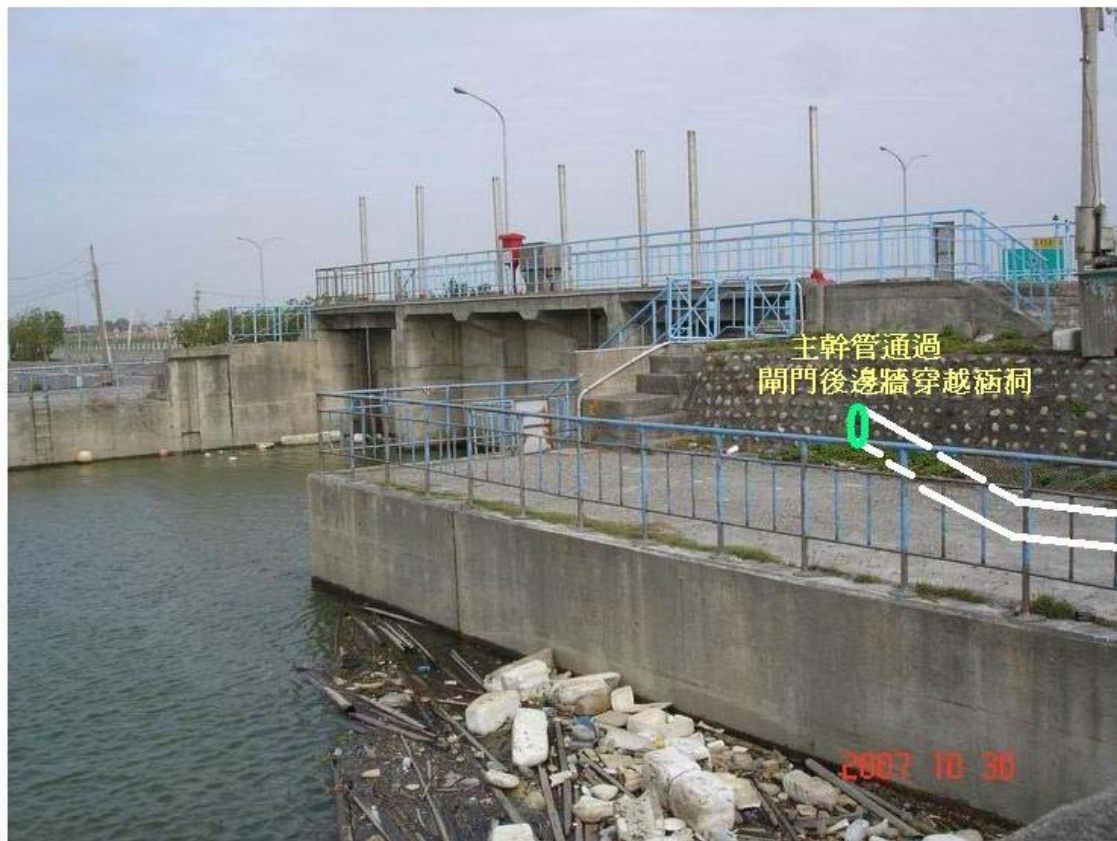
圖 3-12 主要幹管利用大排水溝通過快速公路示意圖
