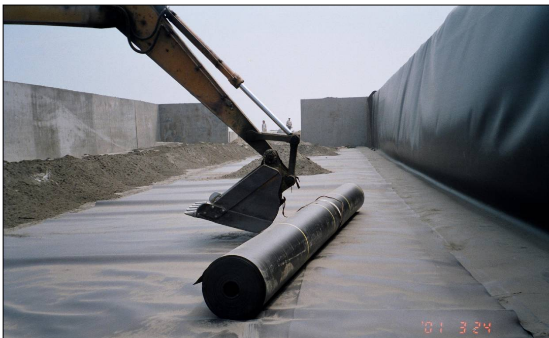
圖 16：滯洪池底設計施工照片
