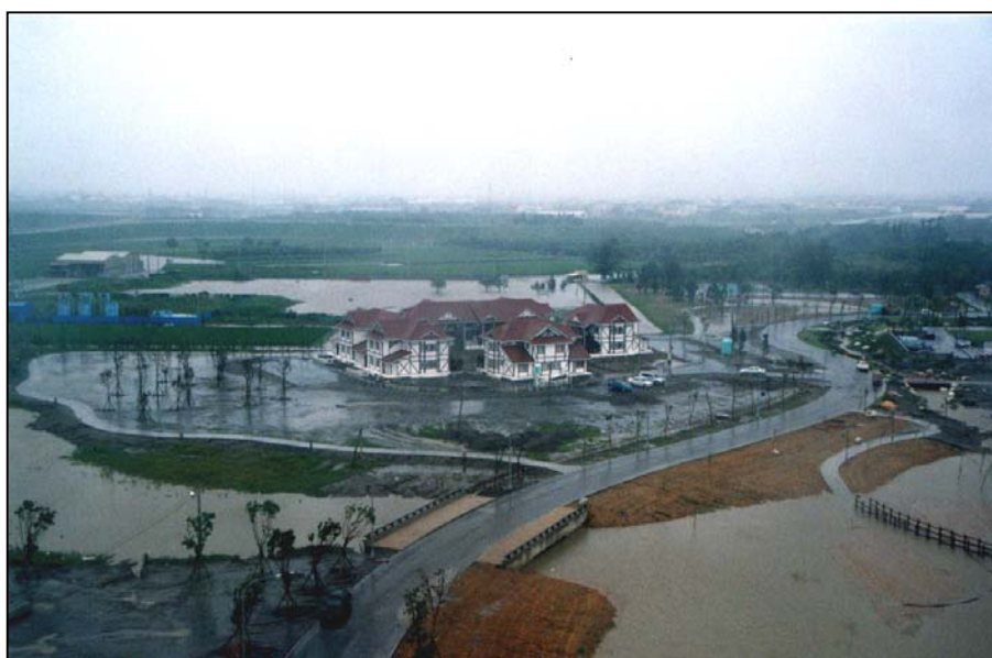
圖 3：滯洪池發揮功效，所有建築物均安然無恙，道路系統亦未受阻；積水情況在 6 小時左右即解除。
