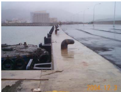
照片 2-1 103 號碼頭靠 104 碼頭端部發生明顯位移
