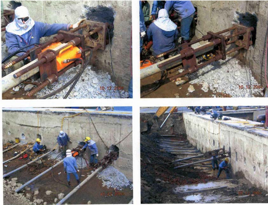
照片 2-6 法線鋼板樁以新製之承拉板拉回（二）
