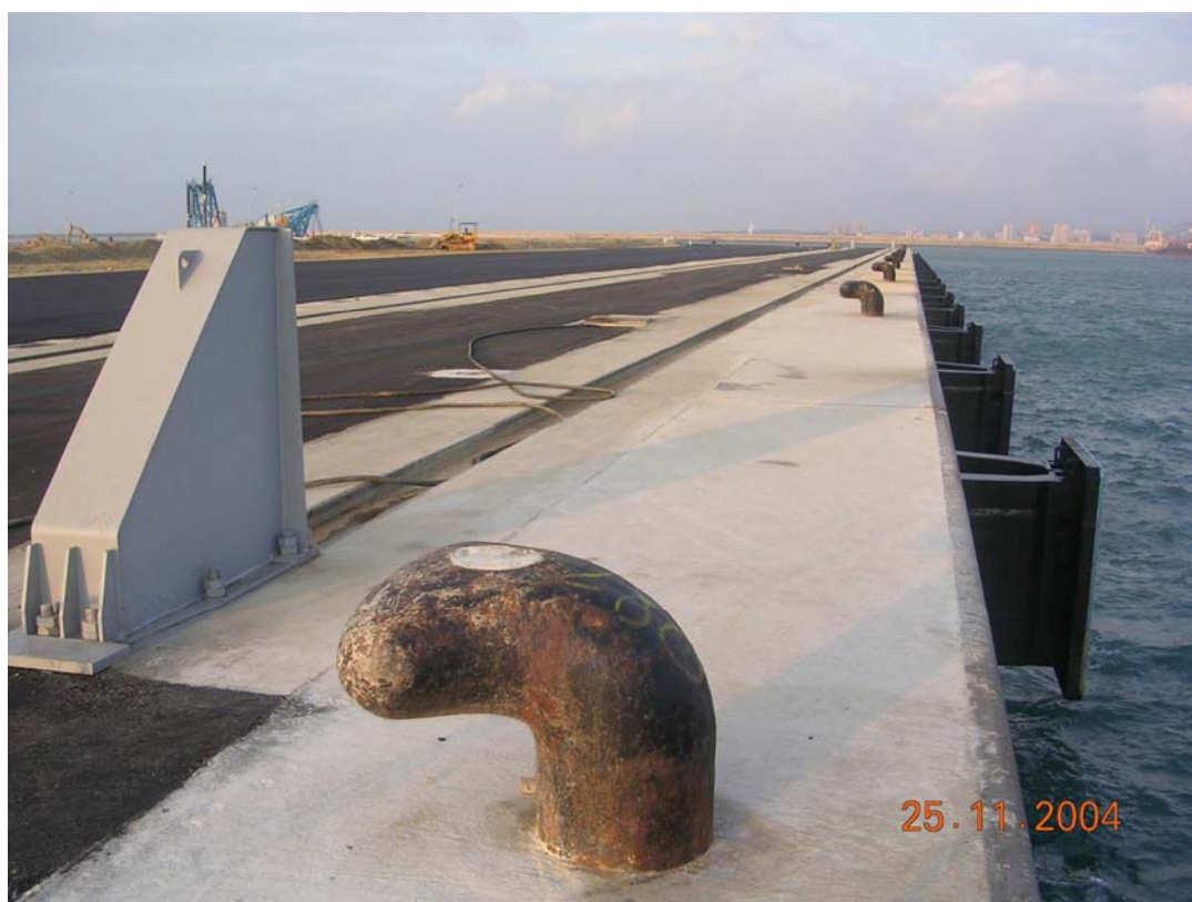
照片 2-7 104 號碼頭完工全景
