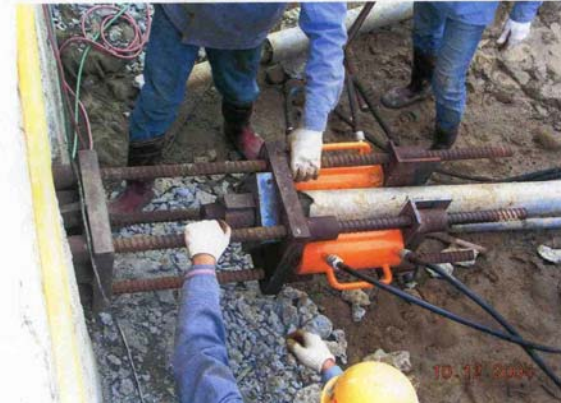
照片 2-5 法線鋼板樁以新製之承拉板拉回（一）
