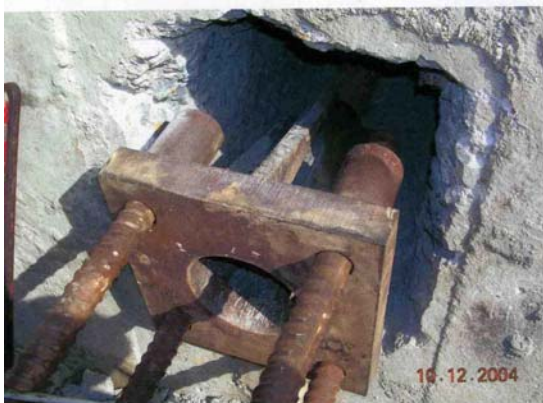
照片 2-5 法線鋼板樁以新製之承拉板拉回（一）
