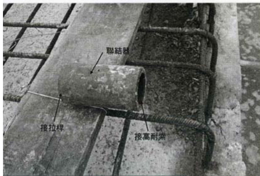
照片3-4 聯結器拆卸照片(一)
