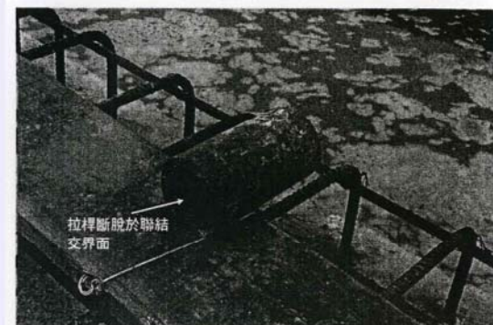
照片3-5 聯結器拆卸照片(二)
