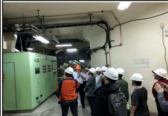
參觀明潭電廠地下廠房
