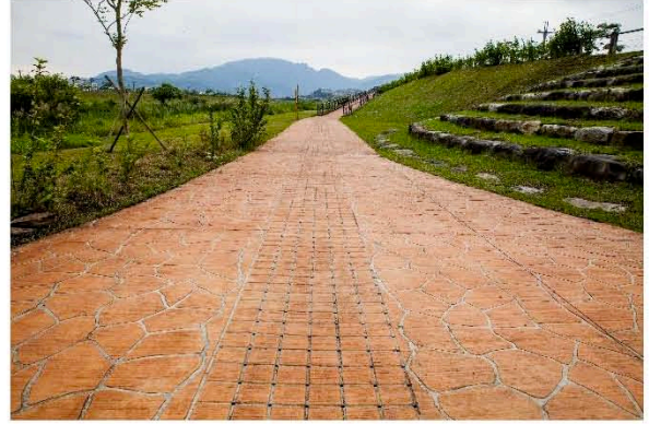
永金一號橋下游段步道及透水鋪面
