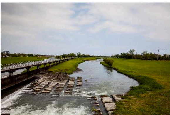
安農溪分洪橋及固床工
