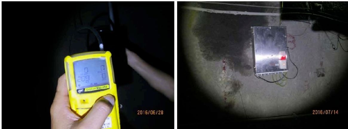
圖14 隧道移動式、固定式氣體偵測
