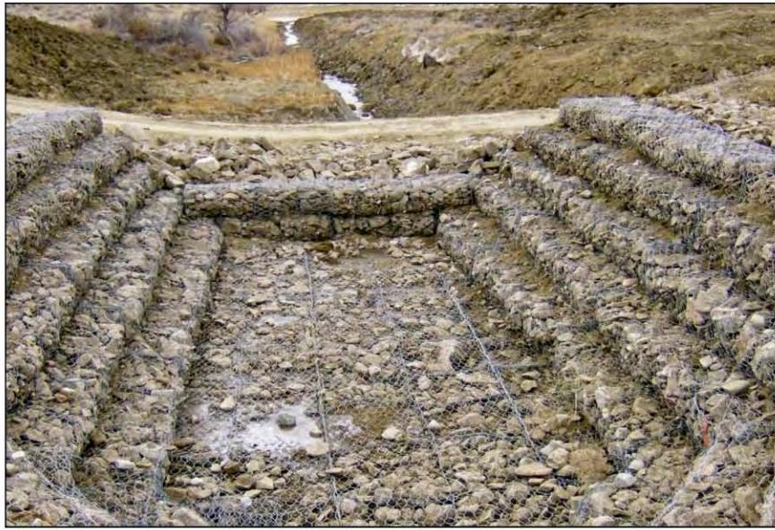
圖 13 塊石坑鋪設石籠代替鋪設塊石
