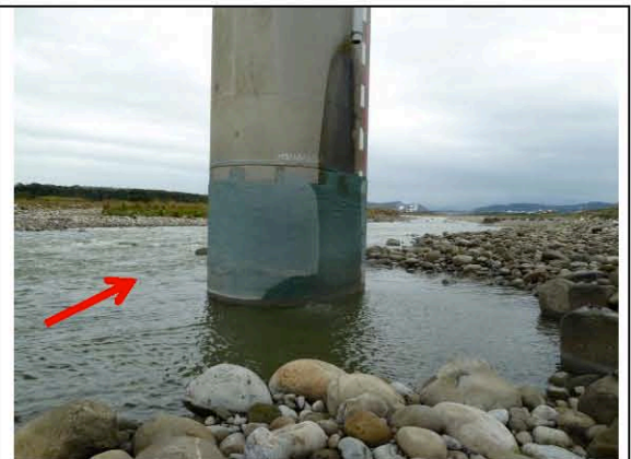
相片1 橋墩前端因受水流撞擊，周遭產生類似馬蹄形之局部沖刷坑
